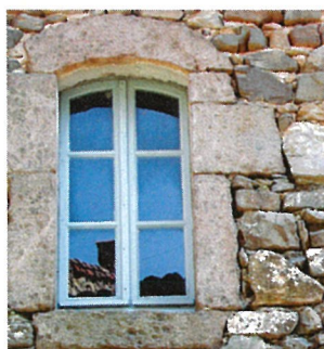
Linteau cintré en pierre Fenêtre à deux vantaux "ouvrant à la française" en bois peint et "petit bois"
