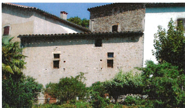
Luziers Les différentes époques de construction sont visibles dans le bâti
