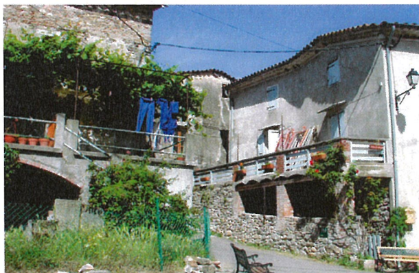
Luziers - Eviter les garde-corps à barreaudage bois, protection type chalet de montagne
