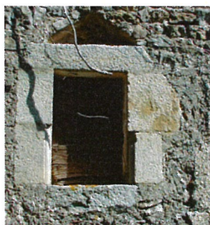
Linteau droit et arc de décharge
