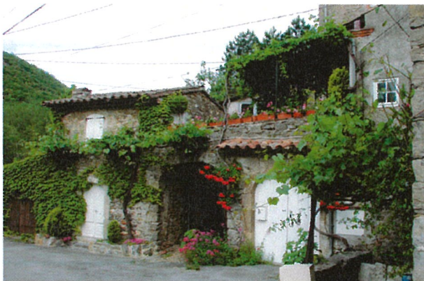
Luziers - Protection en console bois et tuiles
