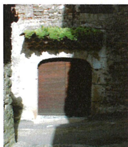
Ouverture : Linteau en "anse de panier"
