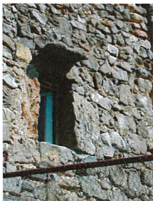
Protection de linteau en pierre
