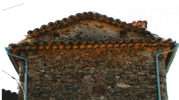
Traitement des pignons. Secteur des Aigladines
