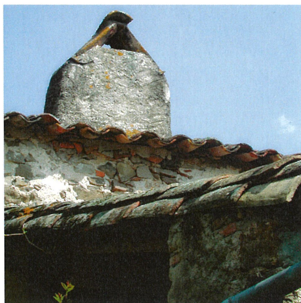
Mas Soubeyran : souches et conduits
