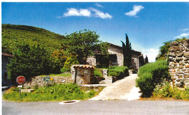
Une architecture en terrasse
