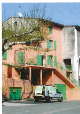
Mialet - Eviter les balcons sur piliers
