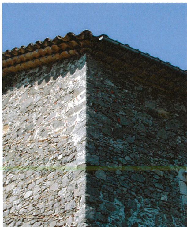
Mas Soubeyran. Débord de toiture
