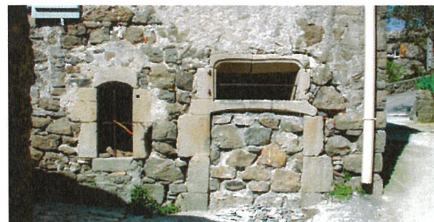
Luziers : traces multiples de modification des ouvertures au fil du temps
