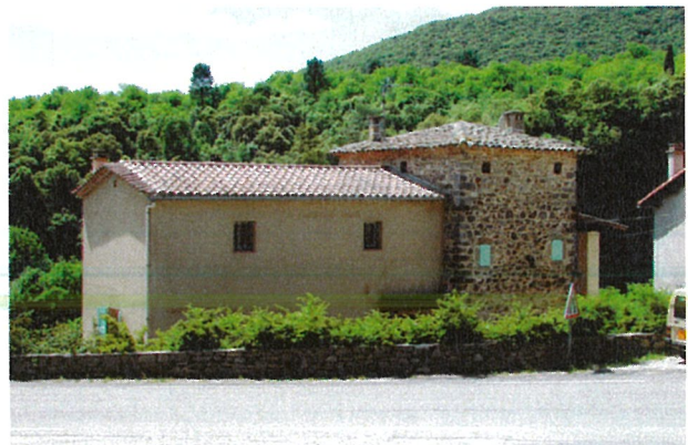
Une extension dont la volumétrie ne tient pas compte de la construction initiale.
