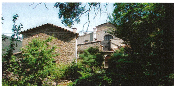
Direction des pignons
