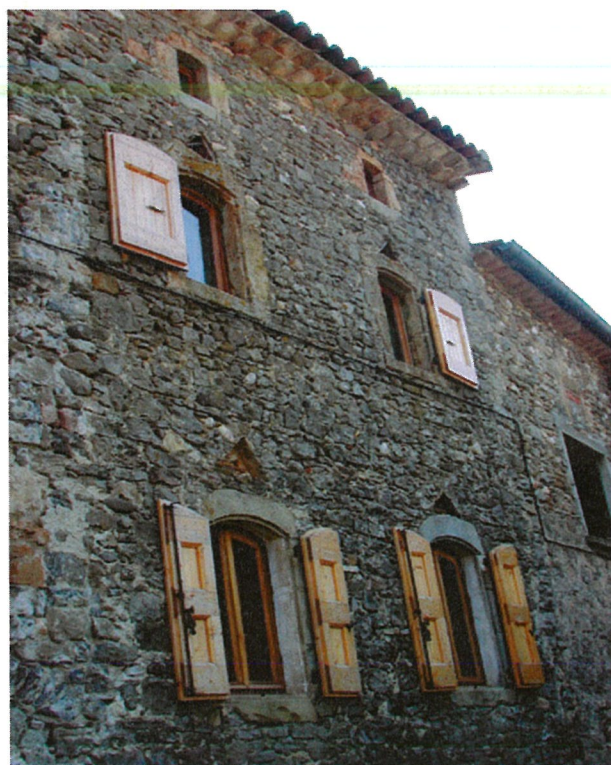
L'ordonnement contribue à l'harmonie des façades
