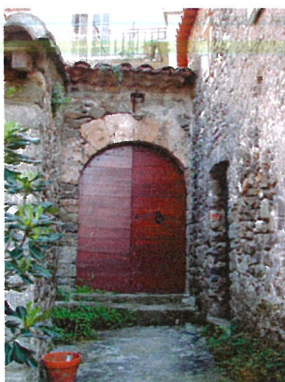
Linteau en arc tendu en pierre taillée
