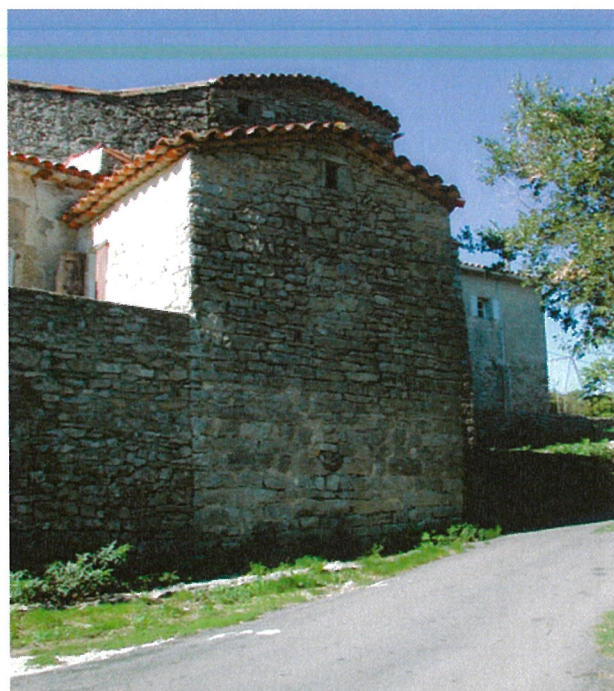
Les Puechs : le traitement des pignons et l'utilisation des génoises
