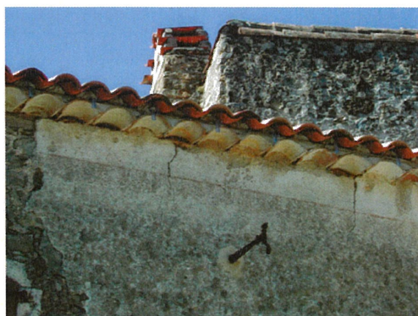
Les badigeons à la chaux soulignent chaîne d'angle, débord de couverture, encadrements de baies.
