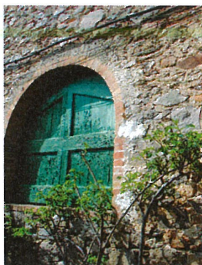
Linteau cintré en brique
