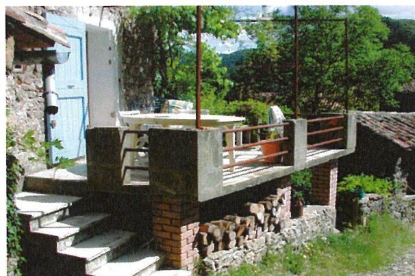
Luziers - Eviter la construction de terrasses dans des matériaux en opposition avec ceux de la construction (ici, béton et briques)
