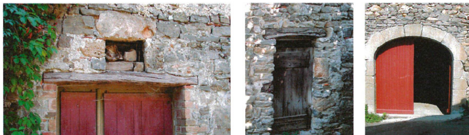
Exemples de linteaux. Source : cahier de recommandations architecturales de Mialet
