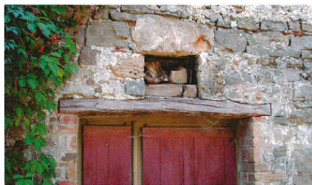
Exemples de linteaux. Source : cahier de recommandations architecturales de Mialet
