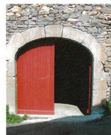
Exemples de linteaux. Source : cahier de recommandations architecturales de Mialet
