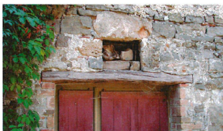
Exemples de linteaux. Source : cahier de recommandations architecturales de Mialet
